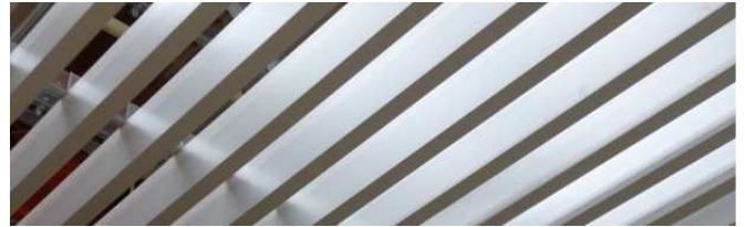
写真1 ルーバー天井
