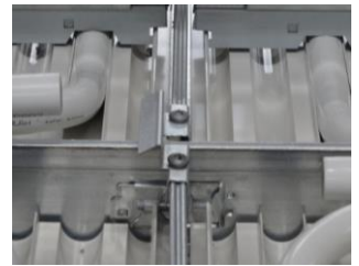
写真4 ジョイントの補強
