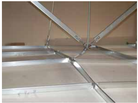
写真 6 従来ハンガー変形状況
