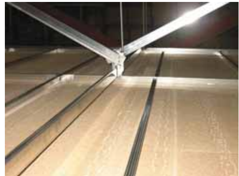
写真2 ラインタイプ試験体設置例
