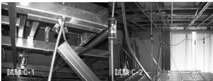
写真 4 終局状況 (部材 C)
