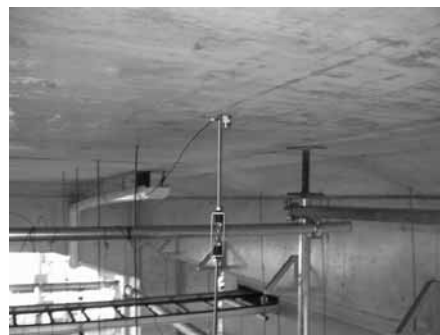
写真2 ピックアップ設置(スラブ面)
