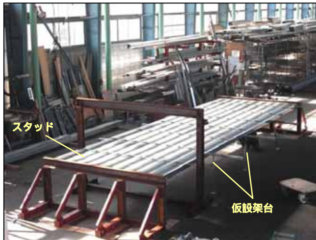
写真 1 試験体全景 (片側面材施工前)
