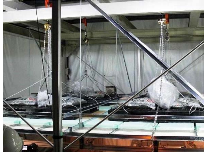
写真3 実験状況（ライン天井載荷時）
