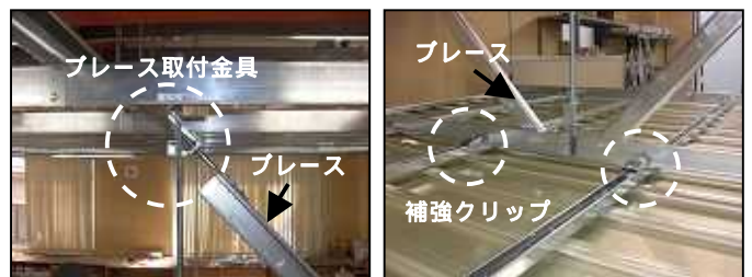
写真2 ブレース取付部詳細
