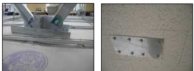
写真4 終局状況(仕上げ材:PB+岩綿吸音板)
