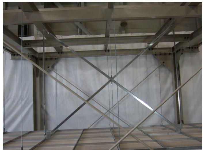
写真4 試験体の例 (No.12 X字1段ブレース配置(逆ハ想定))
