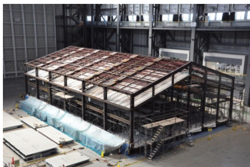
写真1 実大体育館試験体 表1 試験体の主な仕様
