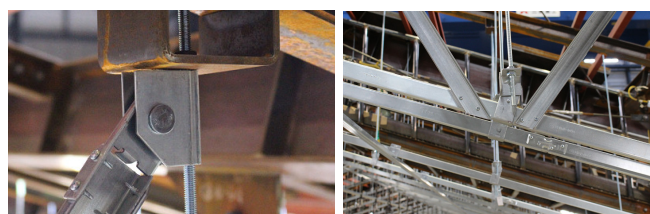
(a)斜め部材上部
