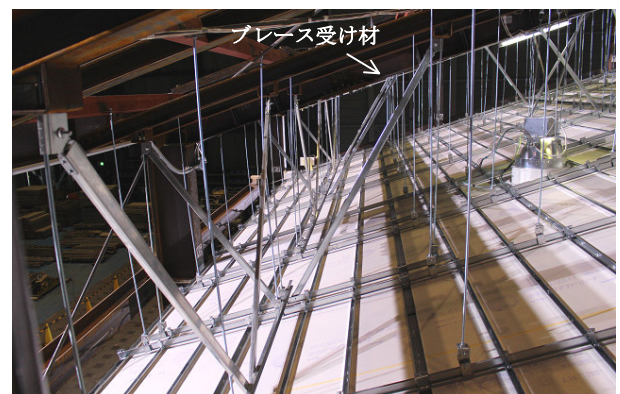
写真1 斜め部材の設置箇所
