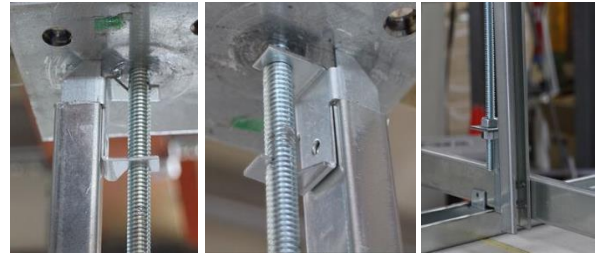
写真2 新工法端部状況
