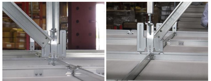
写真2 ブレース下部状況(加力前)
