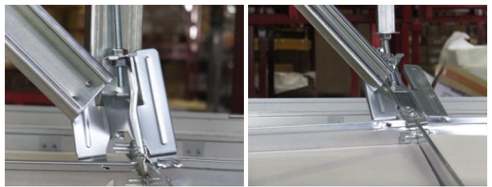
a) 通しブレース b) 2 段ブレース
