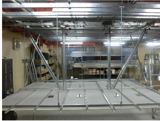
写真2 レ形2組（逆ハ型）補強
