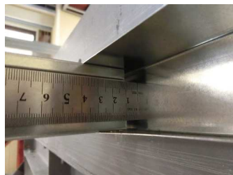
写真2 クリアランス状況
