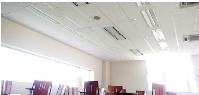
図1 施工事例(帯塗・ワイヤタイプ)
