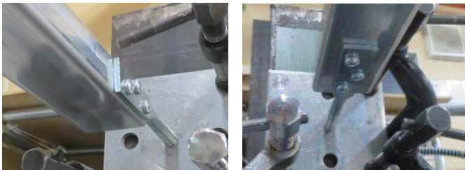
写真1 フランジ面への取付状況
