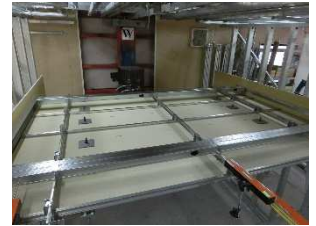
図4 ユニット試験状況
