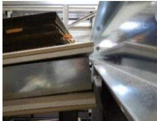
写真5 スタッド上端部 (1-1)
