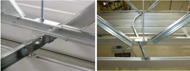
写真5 No1-1 クリップ状況 写真6 No11 野縁受け状況
