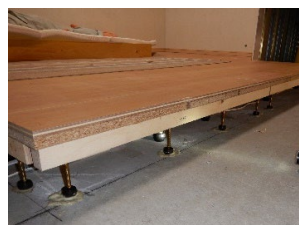
写真 7 乾式二重床状況
