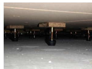
写真 8 乾式二重床 支持脚状況
