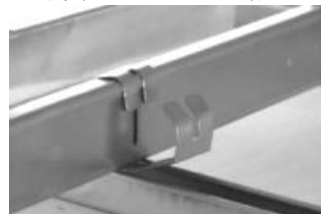
写真4 クリップの外れ
