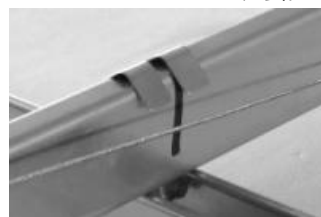
写真2 クリップの緩み
