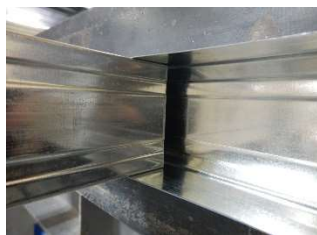
写真4 上部クリアランス
